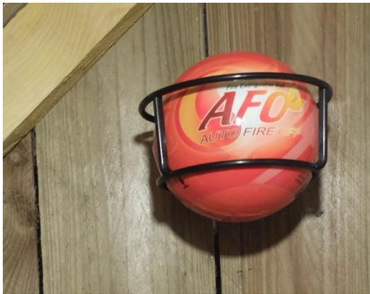
Enfin, il existe des boules extincteurs : elles explosent au contact de la flamme et l'effet de souffle, combiné à une poudre, permet de prévenir un départ de feu. On peut la jeter dessus, mais l'idéal est de la disposer au-dessus du matériel à risque (tableau électrique, onduleur, etc.), c'est très pratique en cas d'absence.
