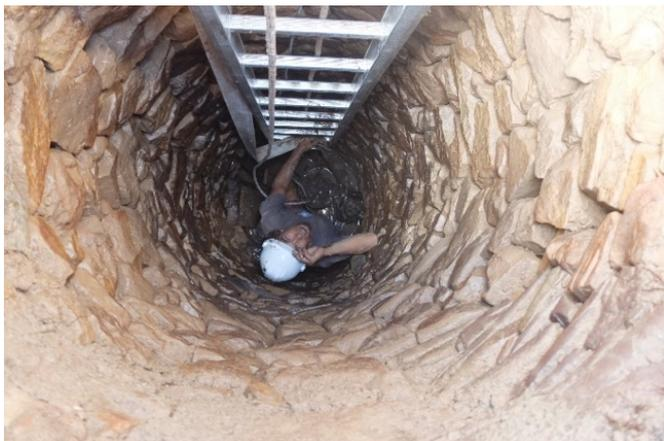
C'est finalement l'épouse de Virgile qui l'a trouvé en faisant des travaux de restauration. Profond de 3,5 m, il a été curé à la main jusqu'à atteindre la profondeur de 8,5 m. Il pourrait être creusé encore plus, mais le débit est suffisant à cette profondeur.
