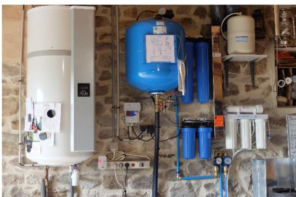
Le puits se situe à 30 m de la maison et dispose d'une pompe immergée, qui approvisionne le ballon à vessie (bleu, au centre de la photo). L'eau passe ensuite dans un système de filtration (les tubes bleus à droite) puis est décontaminée par UV (les tubes blancs). Enfin, l'eau de consommation est envoyée dans l'osmoseur pour une dernière filtration.
